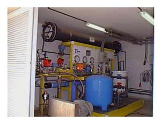
Fig. 9.21 The RO unit at Pozo Izquierdo
