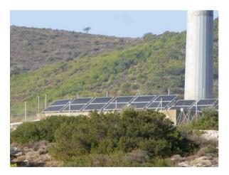
Fig. 9.26 CRES 4 kWp PV unit
