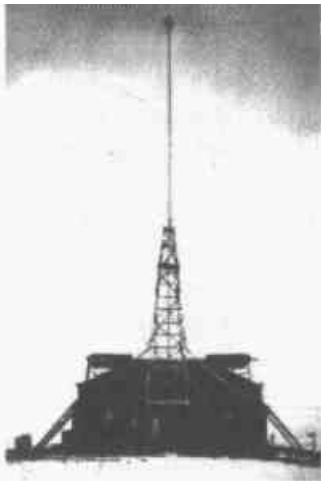
Bild 4: Tesla's 10kW- Magnifying Transmitter
